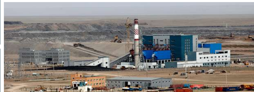
18МВт Ухаа худаг цахилгаан станц – MCSI
